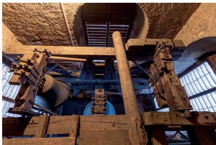
Pohled na současnou zvonovou stolici
